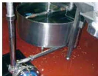
ポンプ設置状況
